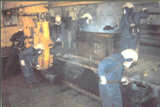
Réfection de cathode : pose de grands joints.
